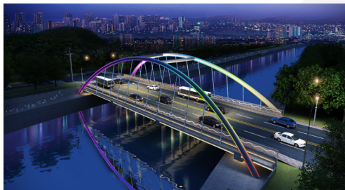
兴隆县 2018 年市政基础设施建设项目西大桥工程
