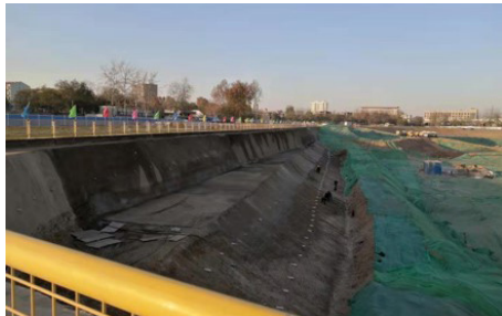
石家庄 CBD 工程基坑监测
