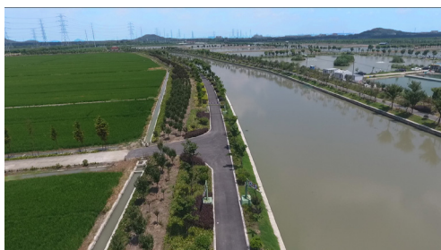
松江区华营港整治工程
