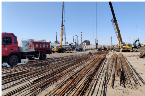
唐山佳华化工园区桩基工程
